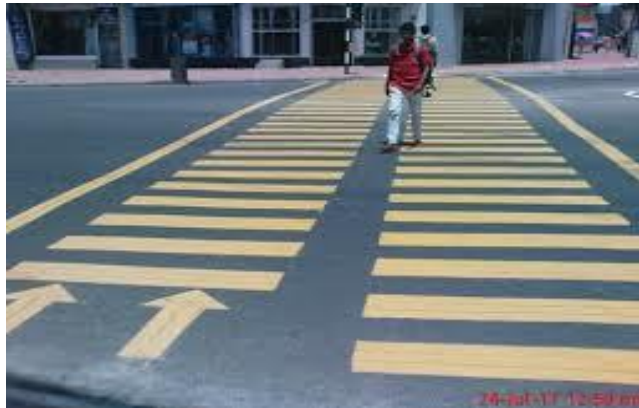
Slika 7. Pješački prijelaz s dvosmjernim tokom prometa
